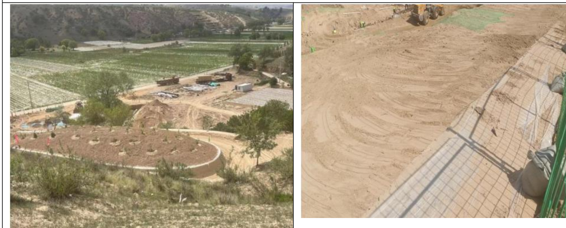
边坡修复及植被绿化
