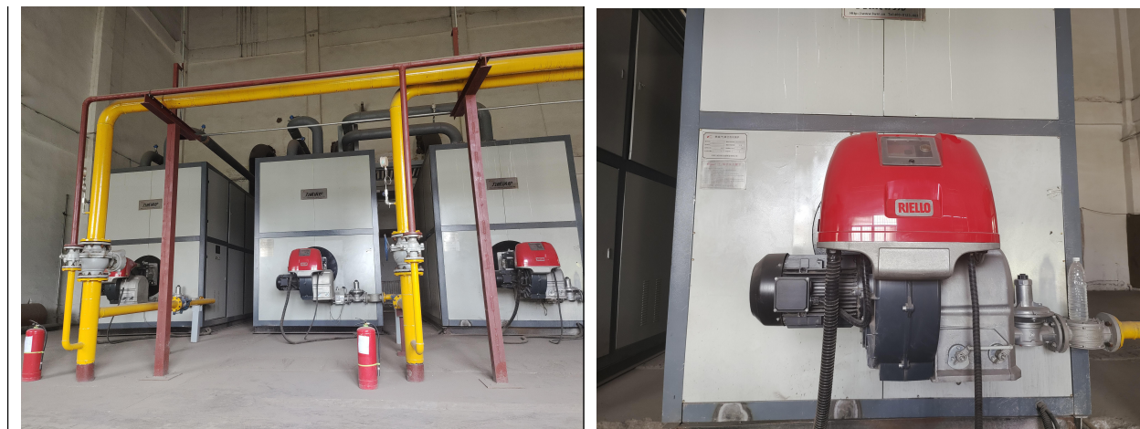
图 3 项目低氮燃烧器图
