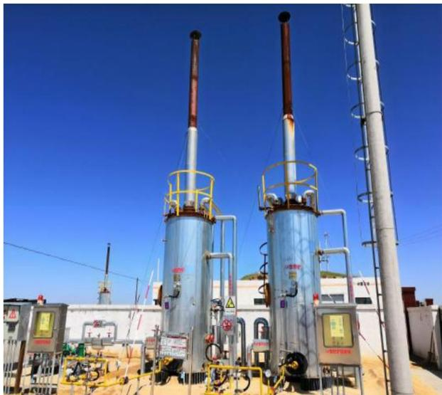
加热炉排气筒
