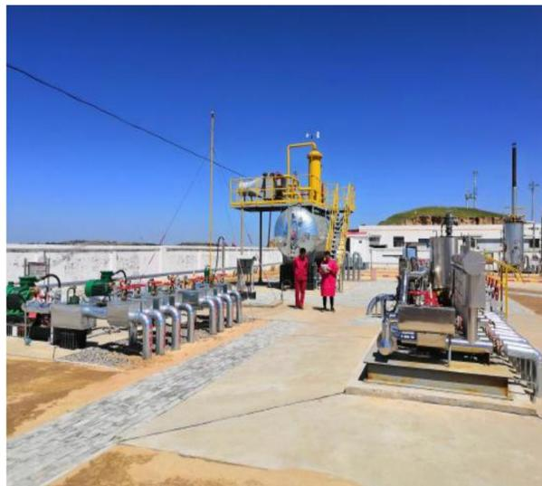
输油泵基础采用钢筋混凝土底座
